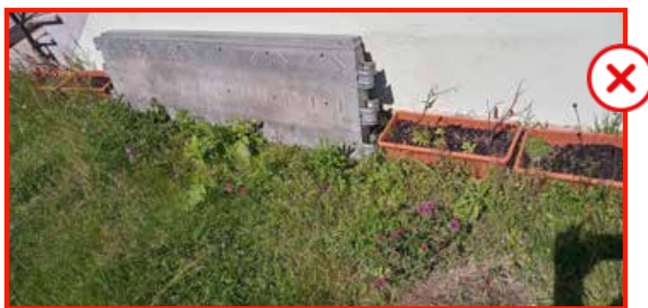
Fig. 2 | Aree esterne con materiale estraneo addossato alle pareti e verde non curato
