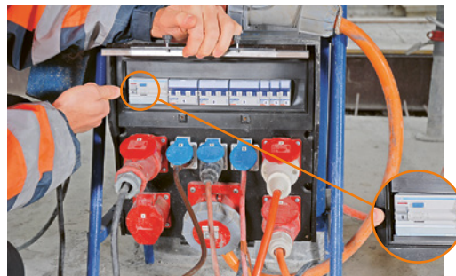
6 Quadro di prese con interruttore differenziale (interruttore FI/RCD). Controllare la funzionalità dell'interruttore FI (prima dell'impiego, secondo le indicazioni del fabbricante).
