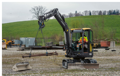
6 Imbracatura corretta di un carico su un escavatore.
