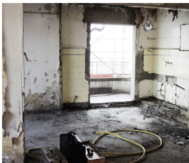
2 Rimozione e demolizione
