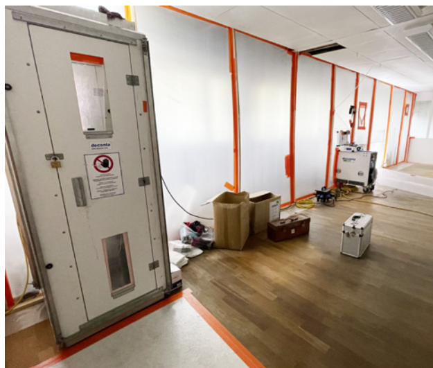
1 Ristrutturazione: zona con estrattore e unità di decontaminazione
