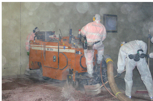
1 Fresa per rivestimenti (tipo «Reprod») collegata a un impianto di depolverizzazione (classe H)
