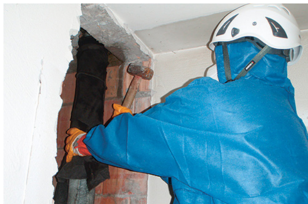
1 Qui un tubo in fibrocemento viene rotto in modo controllato con una mazza.
