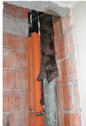
2 Un panno di stoffa viene avvolto nel punto in cui si rompe il tubo.
