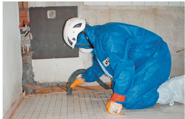
3 Al termine dei lavori la zona operativa deve essere pulita in modo accurato.
