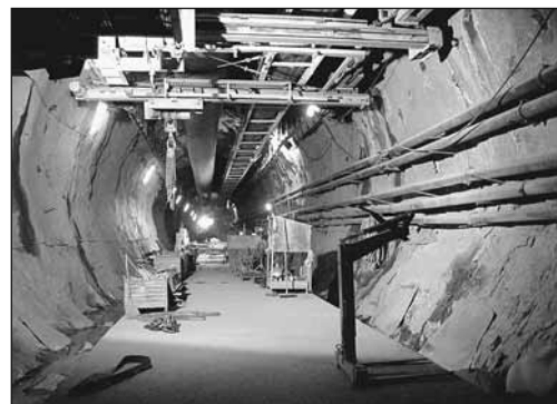
Foto 3: per snellire il flusso di traffico utilizzare un treno di servizio sospeso.
