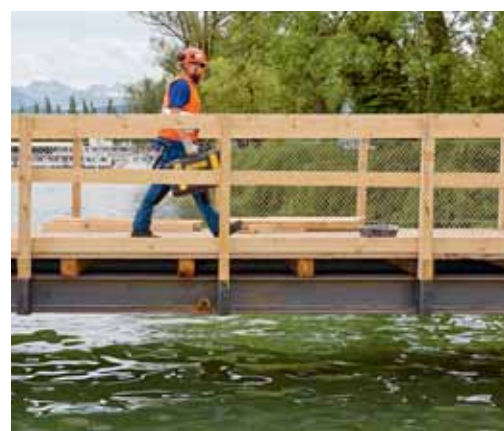
Fig. 5: le misure contro le cadute in acqua devono essere adottate a prescindere dall'altezza di caduta.
