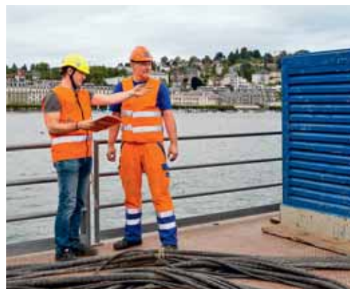
Fig. 1: i lavori vicino, dentro o sopra l'acqua richiedono approfondite conoscenze tecniche e il coordinamento sistematico delle misure di sicurezza.
