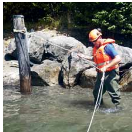
Fig. 11: lavori con waders e giubbotto di salvataggio
