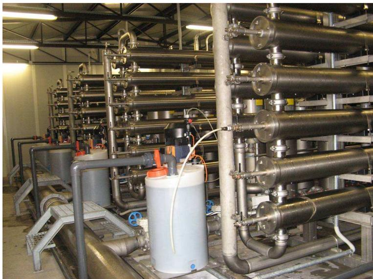
**Figura 1.8** – Centrale di Gorla – Dettaglio delle membrane ad osmosi
