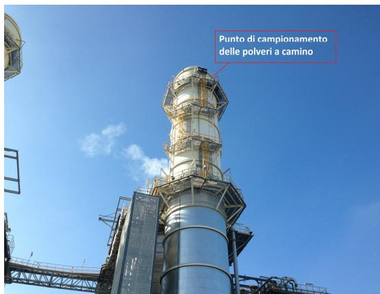
Nella Figura 1.4 sono mostrati due differenti punti di vista della posizione della stazione di campionamento delle polveri a camino.
