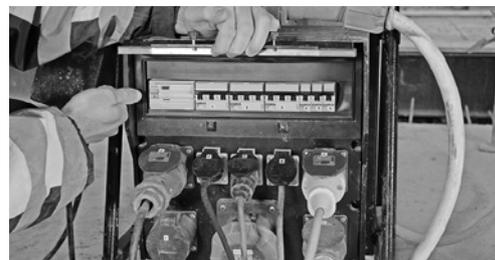
7 Quadro di prese con interruttore a corrente di difetto (salvavita FI/RCD). Testare il funzionamento dell'interruttore FI prima di avviare la macchina e rispettare le indicazioni del fabbricante.
