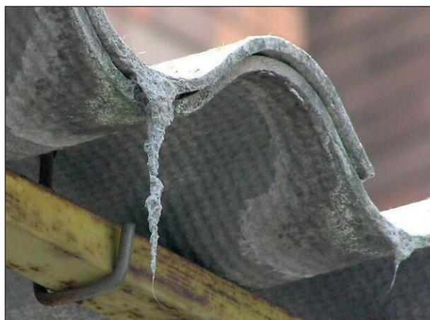
Tali coperture alterate necessitano pertanto di interventi di bonifica, realizzati tramite incapsulamento, confinamento o rimozione e smaltimento definitivo in discarica delle stesse,
