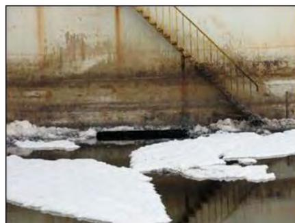
Figura 2. Perdita a seguito di rottura del fondo serbatoio
