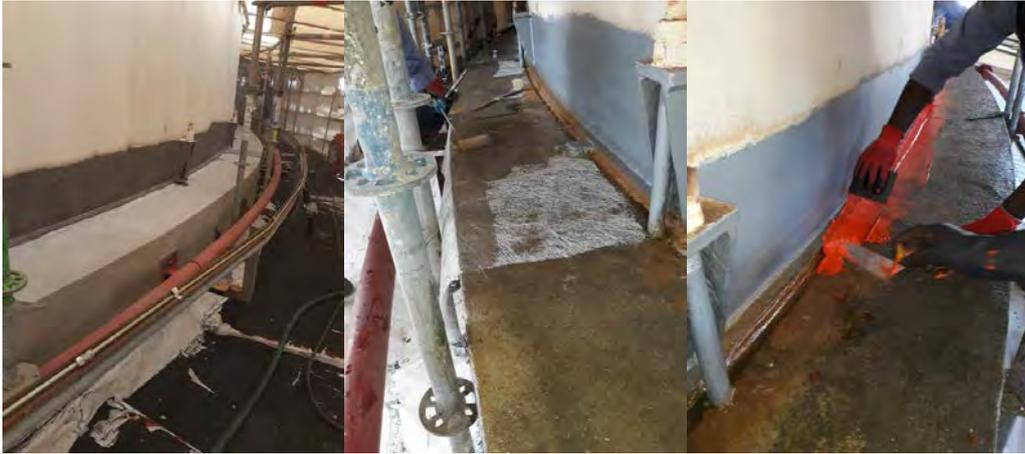
Figura 8. Fasi di lavorazione: sabbiatura, applicazione rivestimento in VTR Liner 1 e sigillatura mediante rivestimento epossipoliuretano
