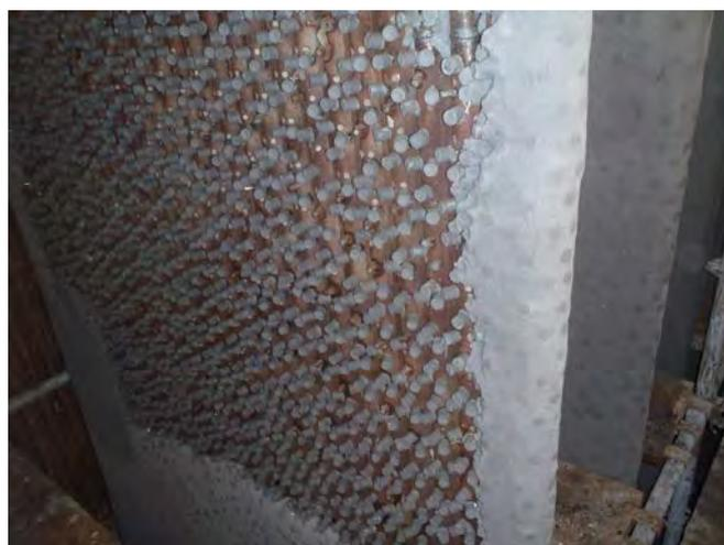
Figura 4. Posa del refrattario
