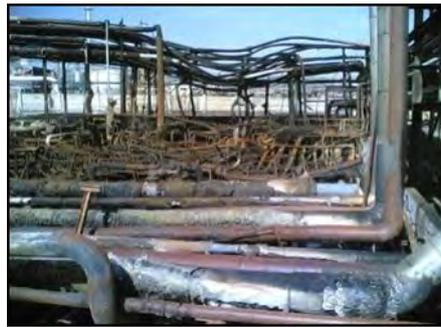
Figura 1. Il rack della pipeline a seguito dell'evento
