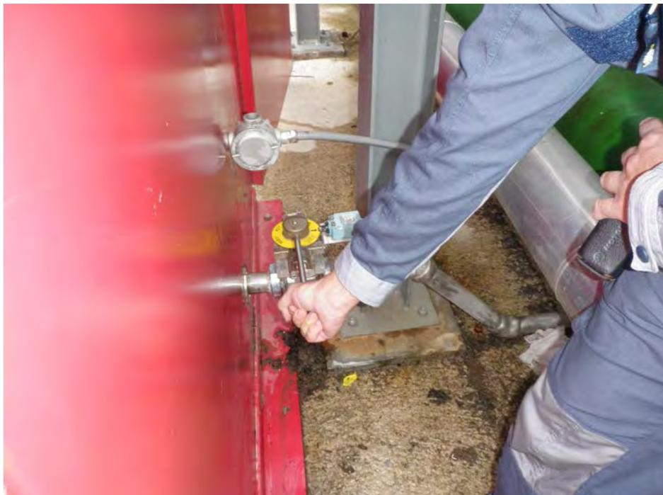
Figura 8. Chiusura della valvola di intercetto CO<sub>2</sub>
