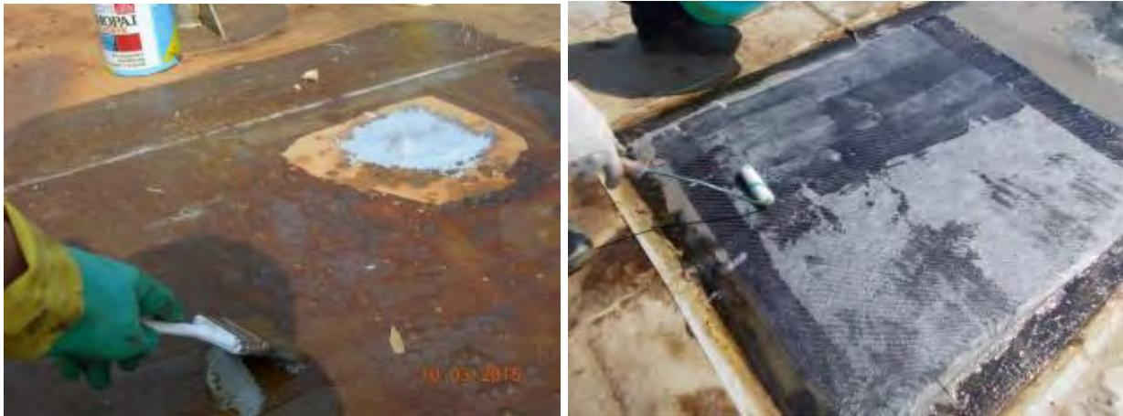
Figura 5. Applicazione primer di adesione dopo seconda preparazione superficiale e fasi di applicazione del laminato
