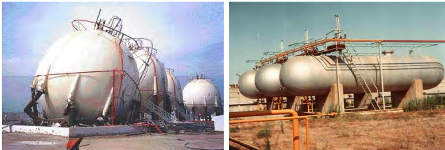
Figura 9. A sinistra: collasso dei supporti di un serbatoio a sfera. A destra: serbatoi orizzontali su selle
