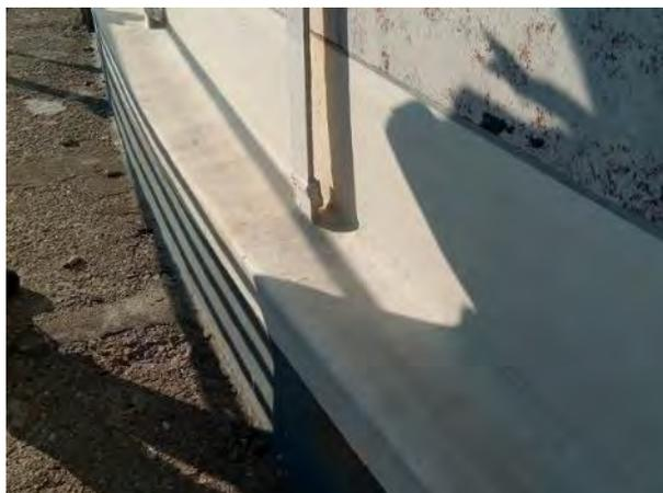
Figura 10. Sistema di rinforzo di un trincarino a 8 anni dall'applicazione
