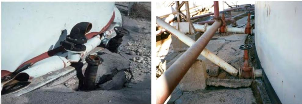
Figura 8. Danneggiamenti alle tubazioni di attacco ai serbatoi e distacco dei giunti flangiati.
