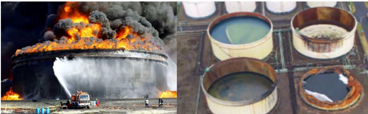
Figura 2.4: Incendio e affondamento del tetto galleggiante
