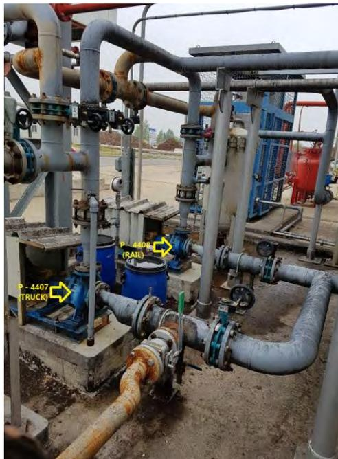
Figura 4. Pompa di trasferimento del bioetanolo
