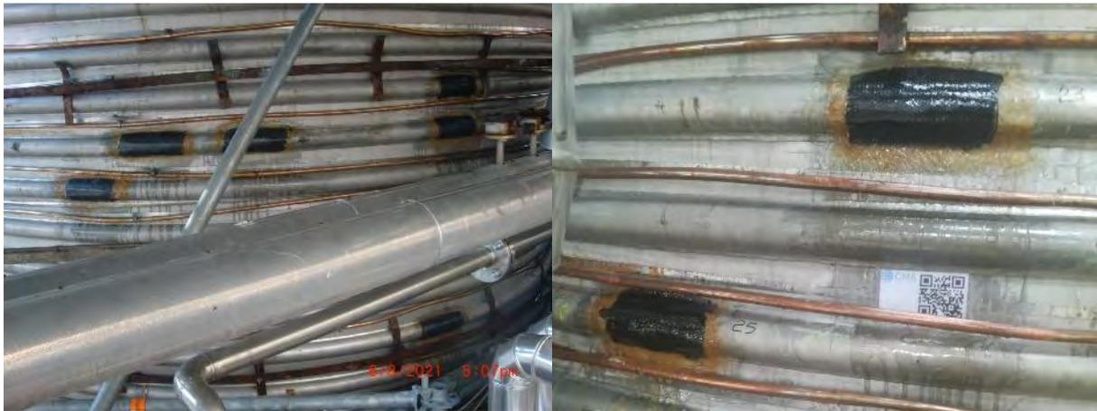
Figura 4. Aspetto finale di alcuni rinforzi; nell'immagine di destra è visibile il QR code identificativo dell'intervento
