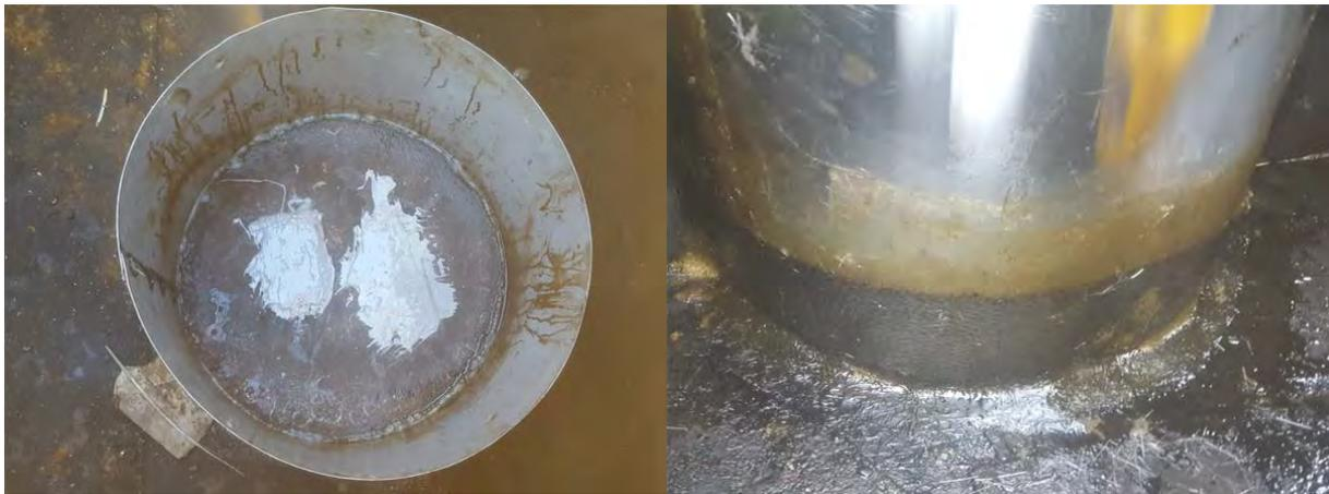
Figura 2. Sigillatura perdita, realizzazione del sistema di contenimento e successiva sigillatura con ciclo PRS
