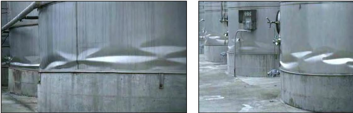
Figura 5. Instabilità elastica "diamond buckling"
