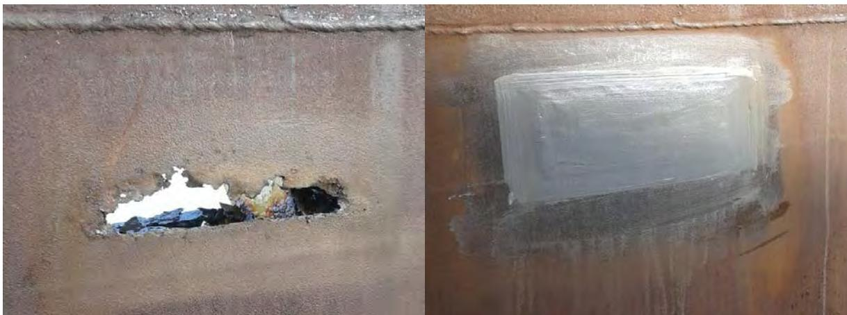
Figura 1. Riparazione difetto passante su mantello serbatoio
