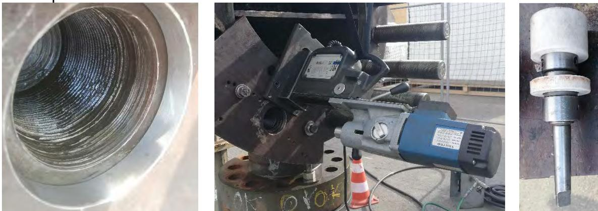
Figura 6. la filettatura danneggiata, il posizionamento del macchinario per l'alesatura, lo strumento di alesaggio
