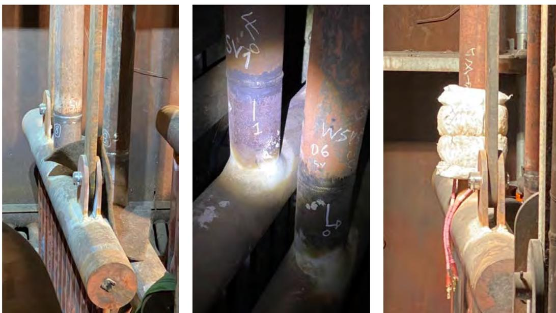
Figura 8. Fasi di saldatura e trattamento termico dei collettori superiori
