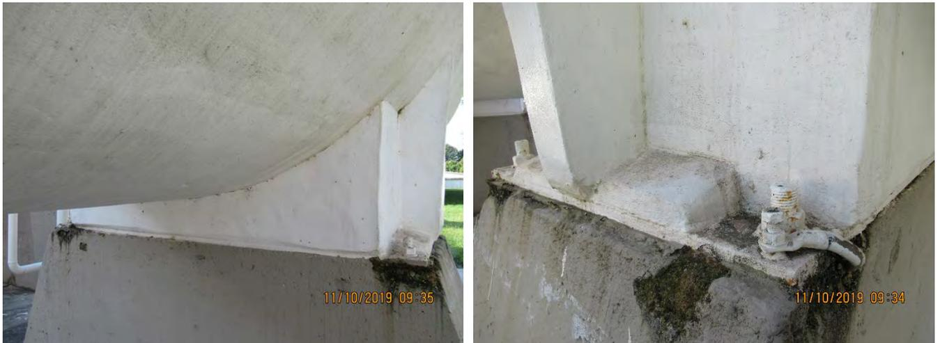
Figura 10. Esempio di collegamento esistente sella/serbatoio in cui la distanza dal bordo è ridotta o il calcestruzzo ammalorato
