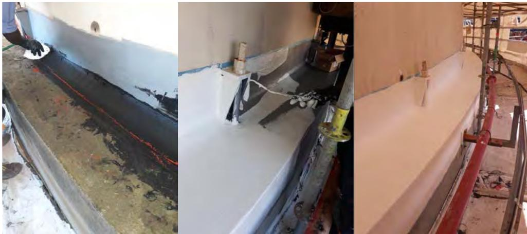
Figura 9. Realizzazione profilo inclinato, deposizione membrana flessibile con rete di rinforzo e aspetto finale
