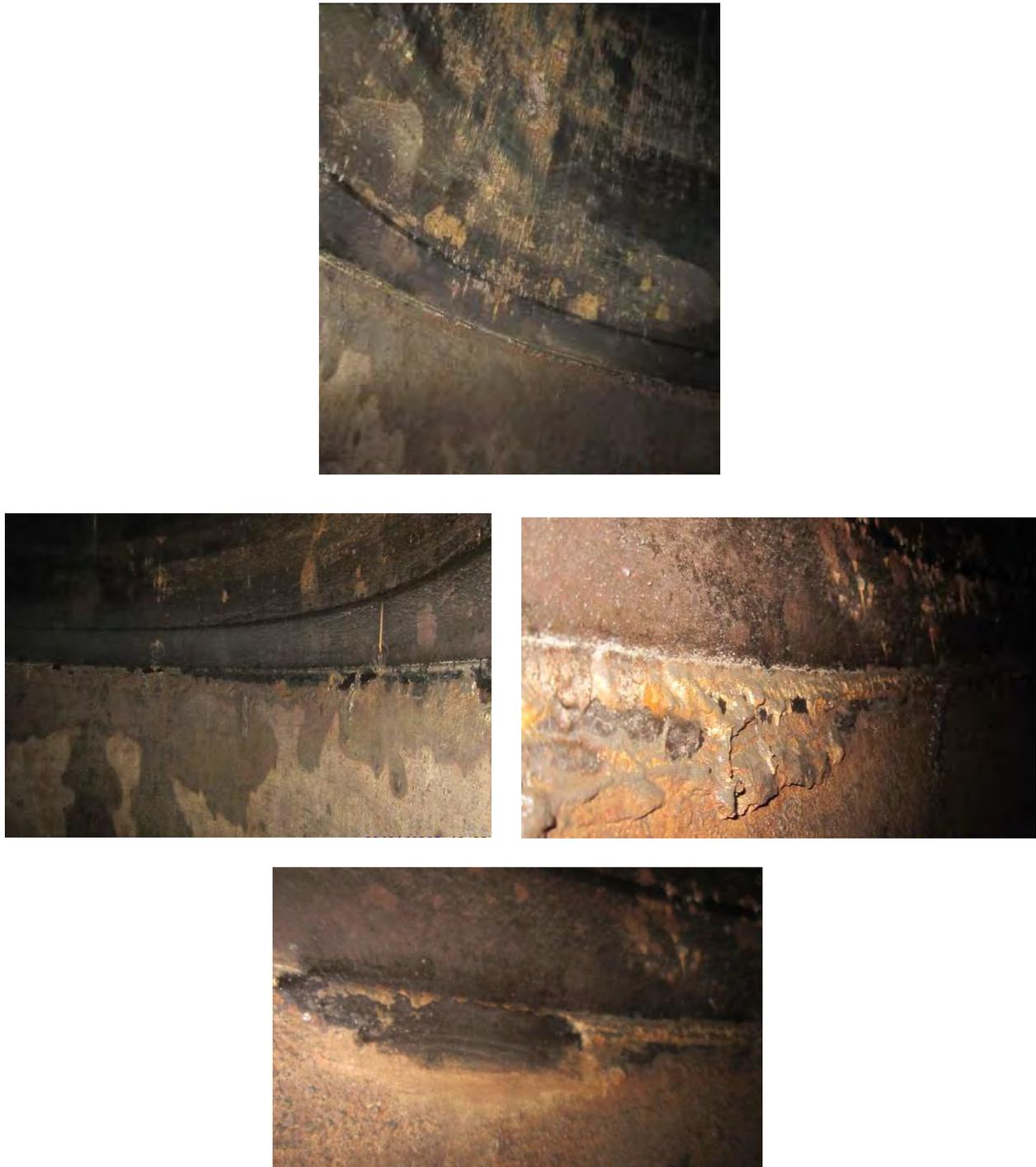
Figura 4. Superficie interna fasciame in corrispondenza dei livelli dell'acqua
