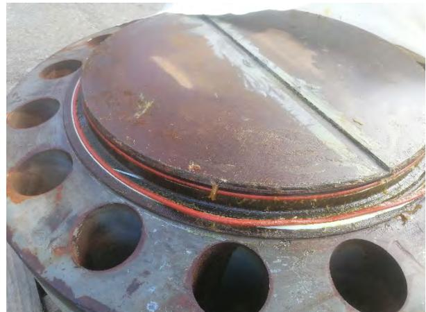
Figura 2. Estratto del disegno costruttivo dello scambiatore con il particolare delle guarnizioni di accoppiamento tra il distributore ed il coperchio ed un'immagine reale del componente
