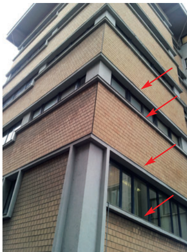
Visione di insieme dell'edificio con indicazione della posizione delle soglie in cemento amianto
